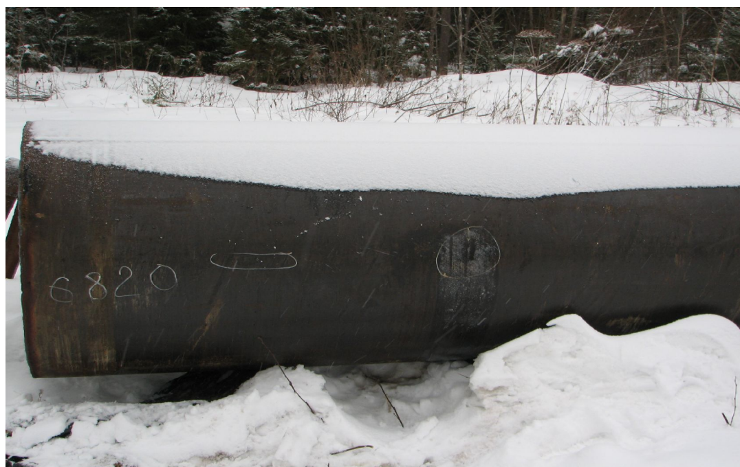
Труба с выявленными с помощью сканера-дефектоскопа А2075 «Сонет» дефектами
